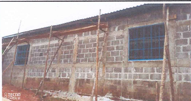
Foto 3: terminando la sustitución de ventanas
