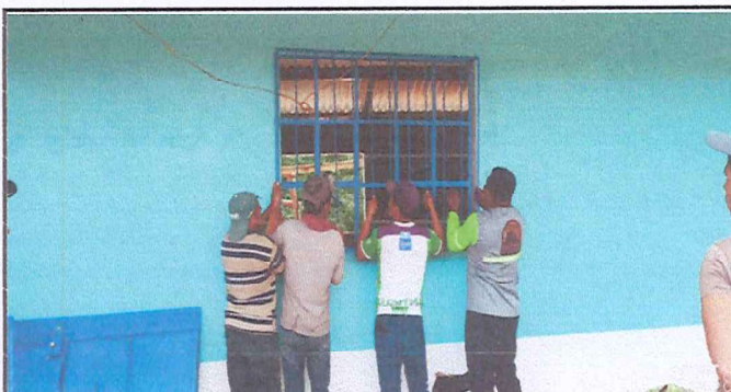
Foto 4: Colocando balcones de ventanas
